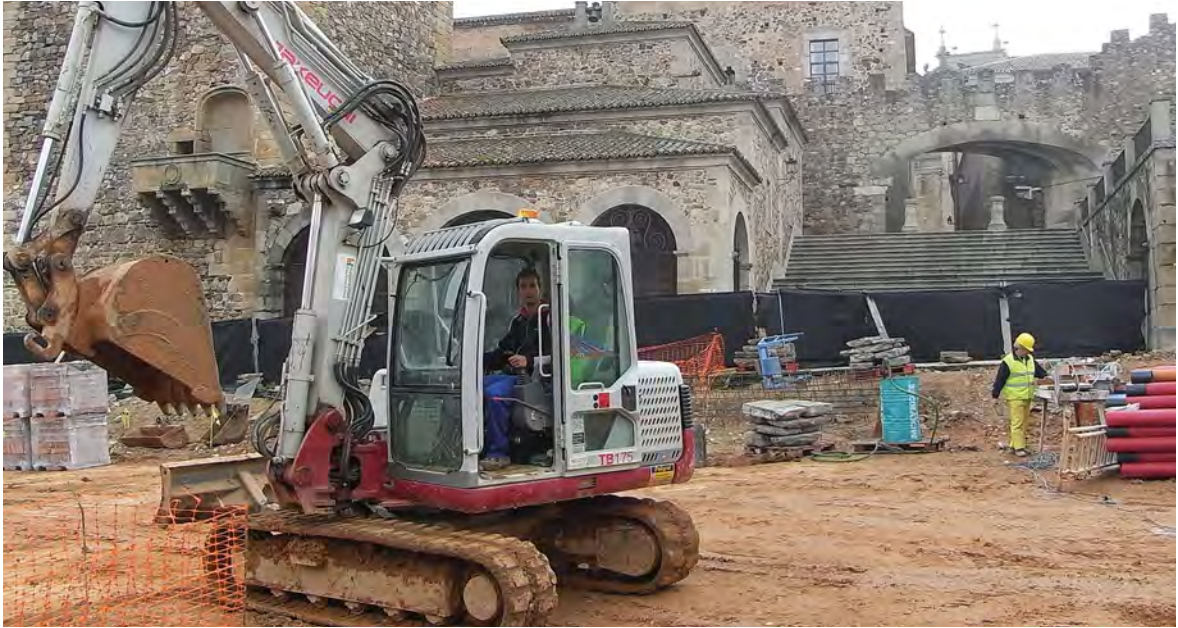
Foto: Trabajando en plena Plaza Mayor de Cáceres.
